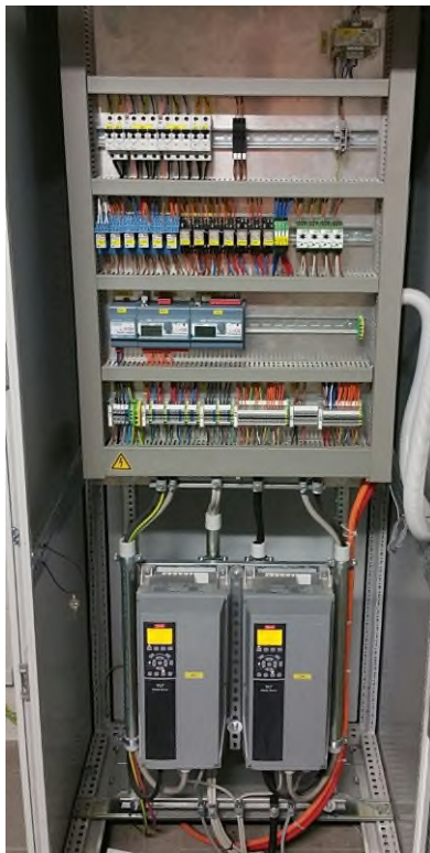
2 Frequenzumrichter je 3,5 kW 60% Leistung = 2.900 m 3 /h 80% Leistung = 4.250 m 3 /h
