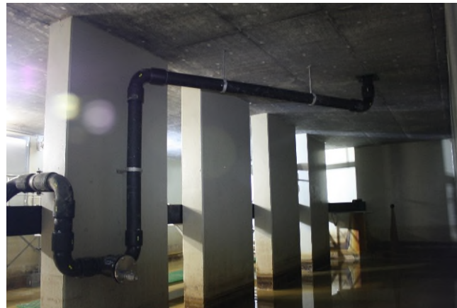
Ansicht: eingefasster Siphon Schlitzrinne
