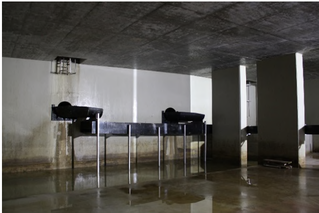
Ansicht: eingefasster Zulauf Süd
