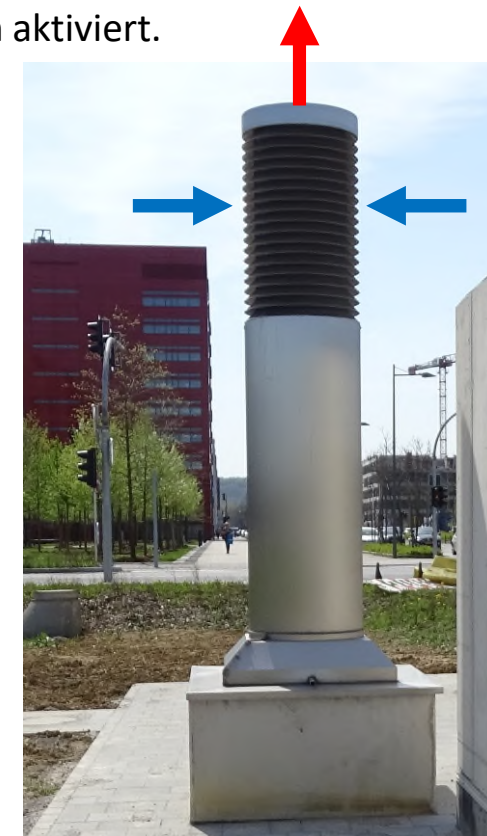
1 kombinierter Ab- und Zuluft Turm
