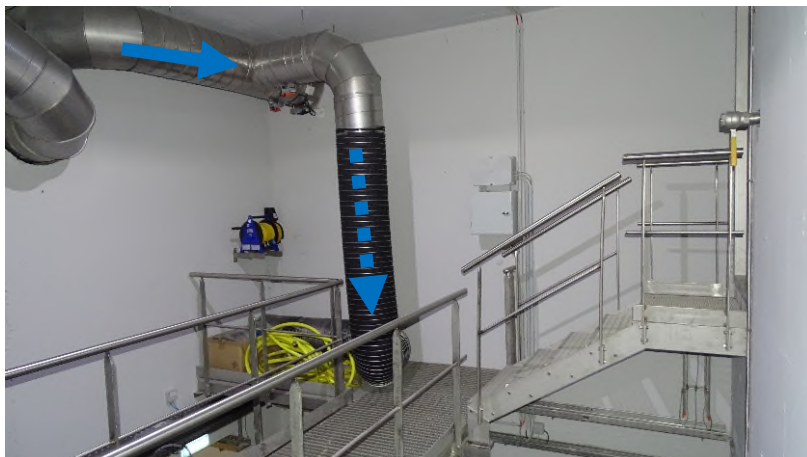
Ansicht Zugang Auffangbecken
