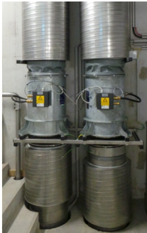
2 Lüftermotore in Ex-Ausführung für Zu- und Abluft aus den Auffang- becken (je 2,5 kW) Ex-Zulassung: II 2 G c
